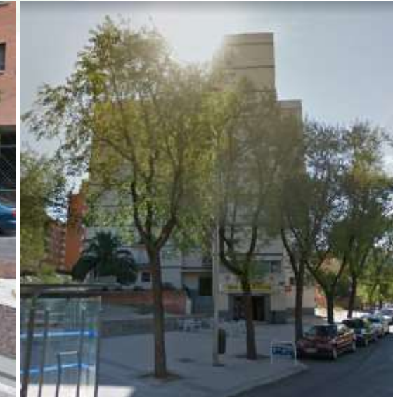
Ronda Sur. Mala adecuación Porte/Marco
