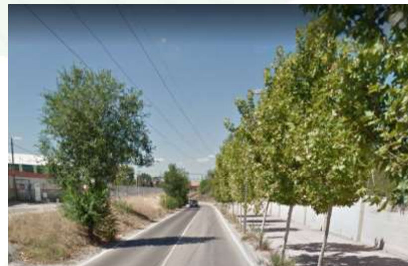
Arbolado en borde de calzada y anillo ciclista Calle Embajadores
