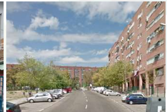
Calle de la Oca Coloreada en amarillo Se observa escasez de cobertura arbolada
