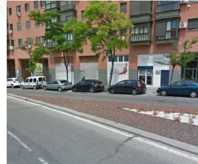
Avenida del Parque de Palomeras Bajas Buena adecuación Porte/Marco
