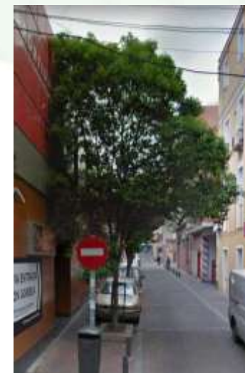
Calle Puerto de Alcolea Mala adecuación Porte/Distancia
