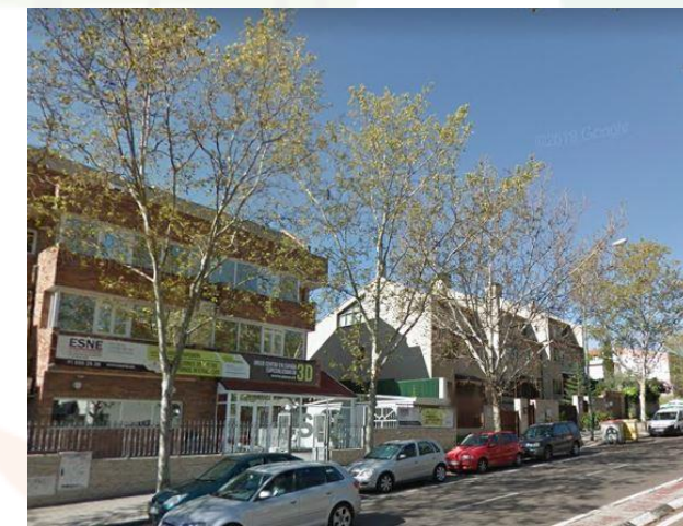
Calle del Moscatelar Buena adecuación Porte/Distancia
