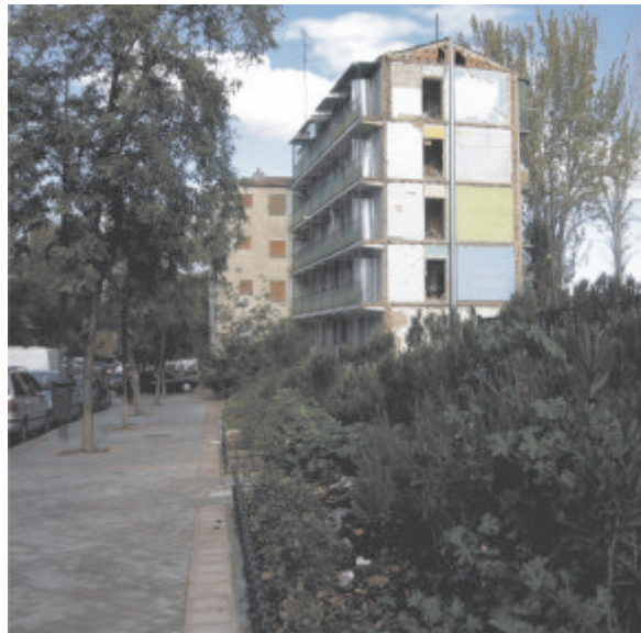
DEMOLICIÓN DE EDIFICIOS EN EL BARRIO DE SAN FRANCISCO JAVIER Y NUESTRA SEÑORA DE LOS ÁNGELES
