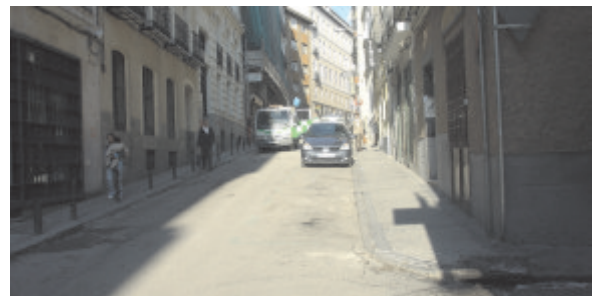
CALLE DE MORATINOS. ANTES Y DESPUÉS DE LA INTERVENCIÓN
