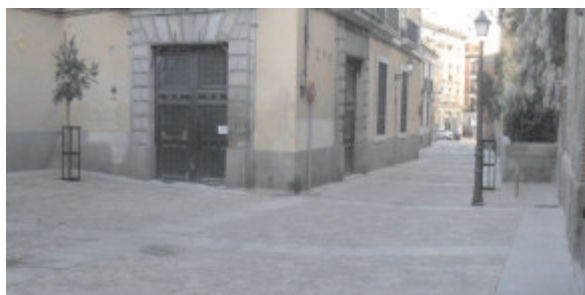
CALLE DEL NUNCIO. DESPUÉS DE LA INTERVENCIÓN
