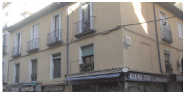
LUÍS VÉLEZ DE GUEVARA, 20. ANTES Y DESPUÉS DE LA INTERVENCIÓN
