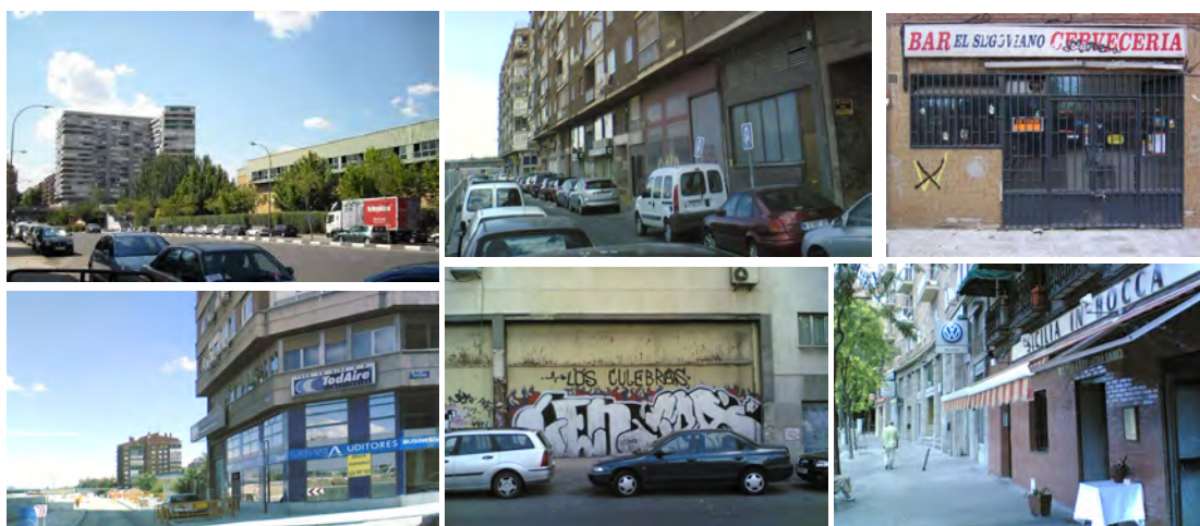
Fig. 26. Arriba a la izquierda, área del CEDEX en el puente de Praga. Imágenes del estado actual de locales comerciales en el ámbito
