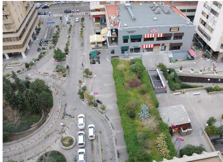
JARDINERA ELEVADA Y CASETA DE VENTILACIÓN SIN USO , A DEMOLER, PARA LIBERAR VISUALES DESDE EL ACCESO DESDE LA AVENIDA DEL GENERAL PERÓN, HACIA EL CENTRO DE LA PLAZA
