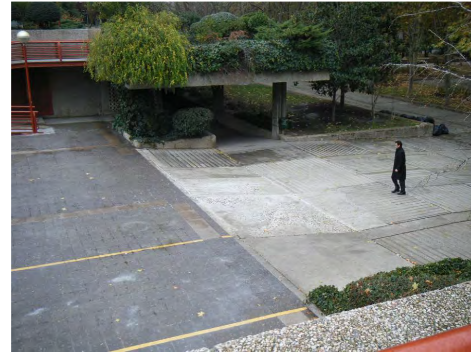
GRAN ACCESO DESDE LA CASTELLANA. LA PROPUESTA MANTIENE LIBRE DE OBSTÁCULOS LA CIRCULACIÓN DE EMERGENCIAS QUE HAY EN LA ACTUALIDAD
