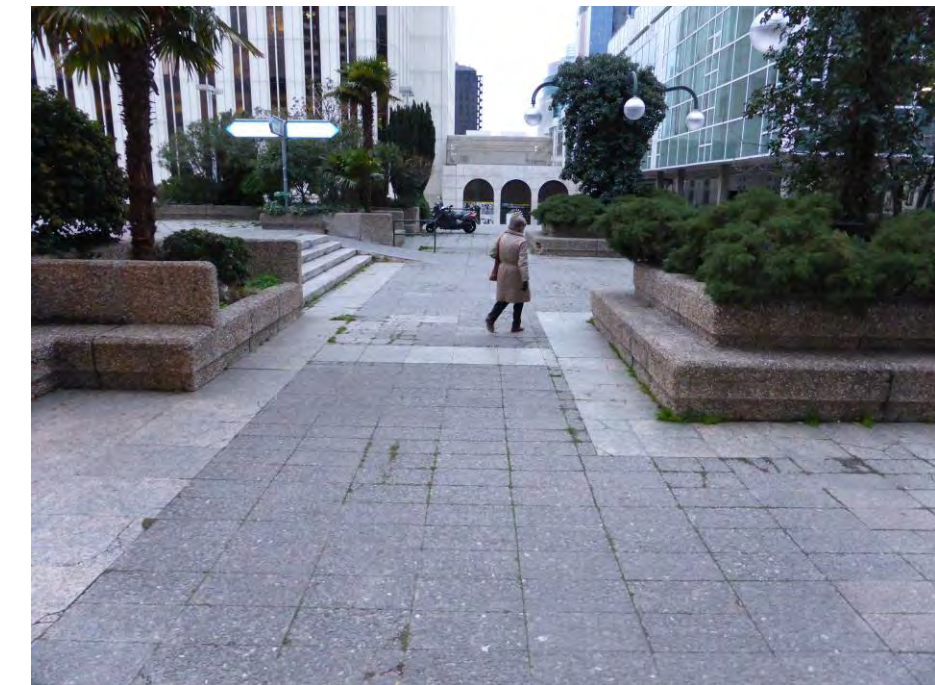
JARDINERAS EXENTAS A ELIMINAR Y ZONA DE ESCALERA A REALIZAR RAMPAS PARA LOS BOMBEROS Y EMERGENCIAS
