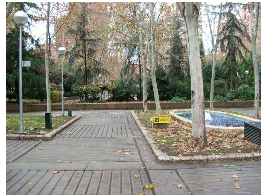
VISUAL DESDE CASTELLANA HACIA ORENSE DONDE SE PREVÉ EJECUTAR EL ITINERARIO PRINCIPAL, PARA LO QUE ES NECESARIO DEMOLER MURO ENTRE LOS CEDROS Y EL LEVANTADO DE LA FUENTE PEQUEÑA
