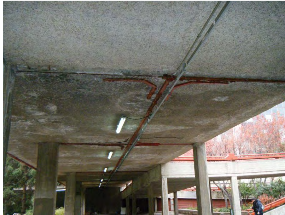
FORJADO A DEMOLER PARA LIBERAR VISUALES DEL ACCESO SUR, DEBIÉNDOSE EMPEZAR DESDE LAS ESCALERAS Y LA RAMPA
