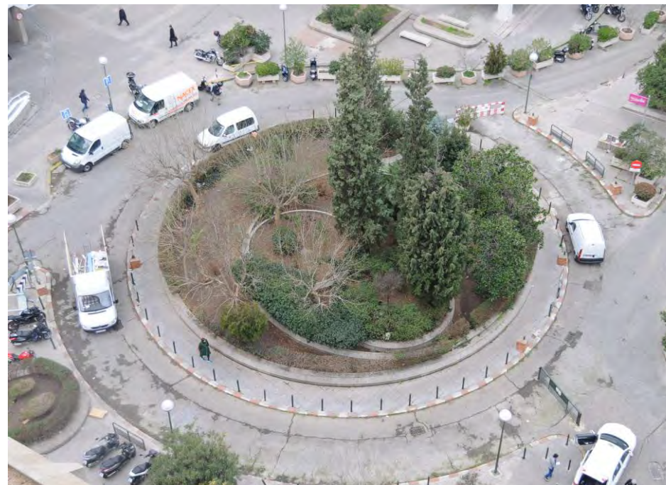
ROTONDA CENTRAL A RECONFIGURAR , ELIMINADO EL TRÁFICO Y LA FORMA CIRCULAR PERO MANTENIENDO EL ARBOLADO DE PORTE
