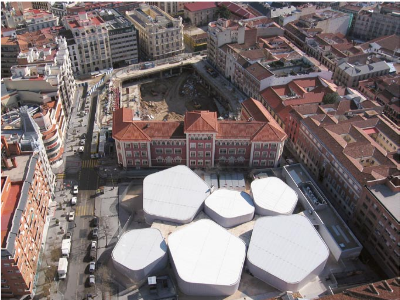
Mercado temporal en primer plano. A continuación, inicio de las obras de construcción del Centro Polivalente de Barceló.
