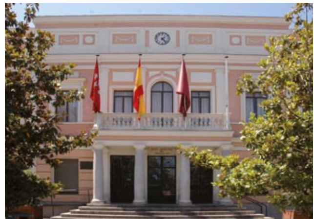
Sede de la Junta Municipal del distrito de Puente de Vallecas. Fachada principal.
