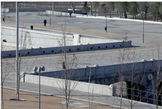
Puente del Rey. Enero 2010.
