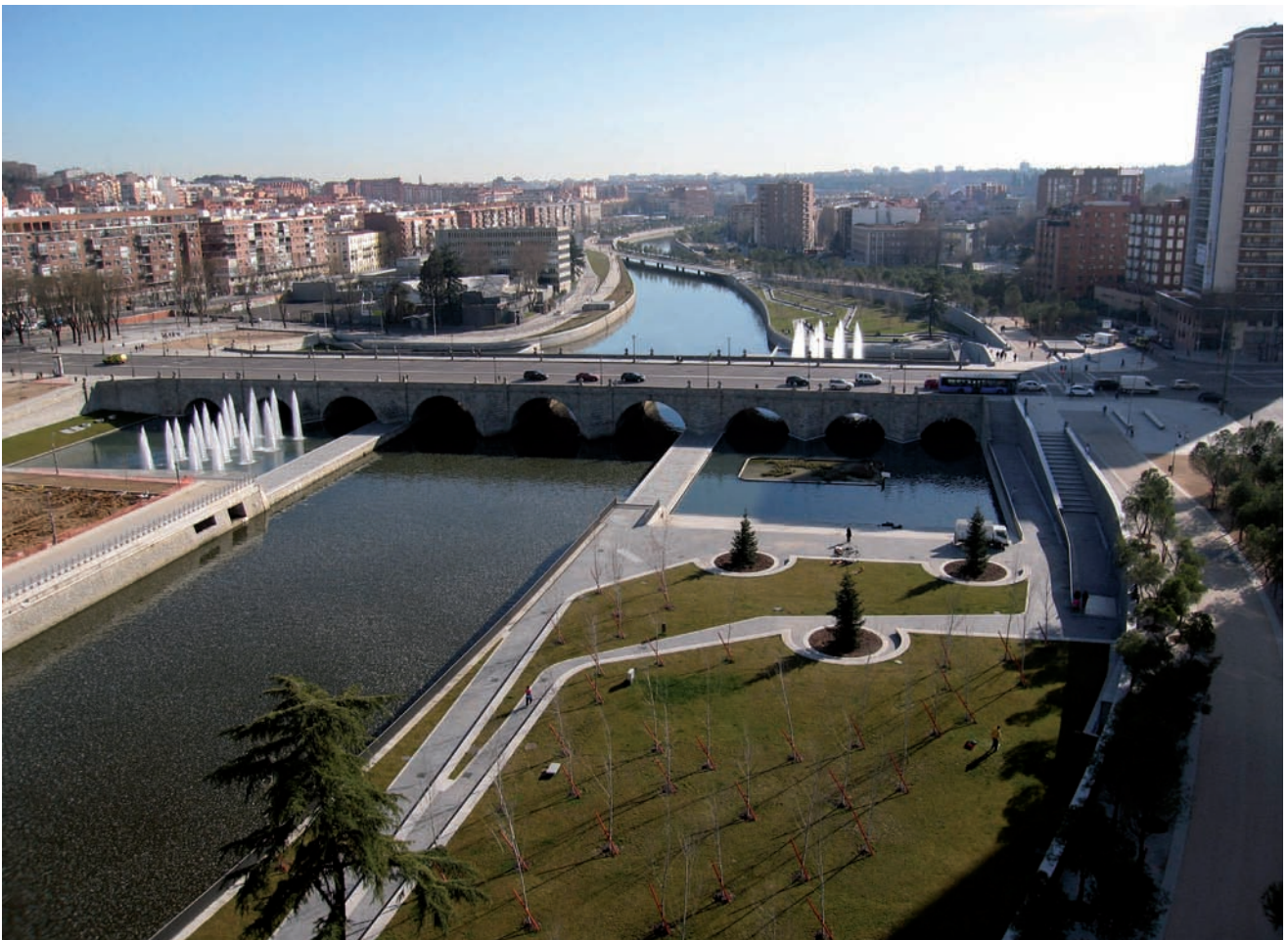
Puente de Segovia y jardines de su entorno, puente Oblicuo al fondo. Febrero 2010.
