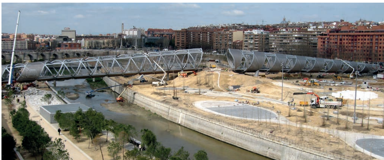
Pasarela peatonal Arganzuela II en obras. Diciembre 2010
