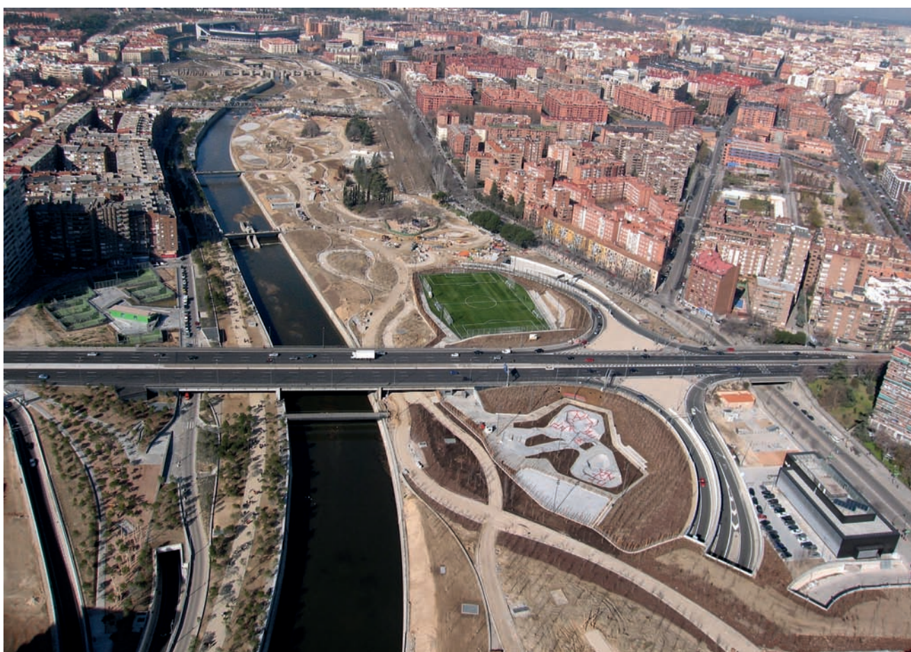
Junto al puente de Praga, pistas deportivas y de patinaje del parque de la Arganzuela. A la derecha de la fotografía, nuevo Centro de la Policía Municipal. Diciembre 2010
