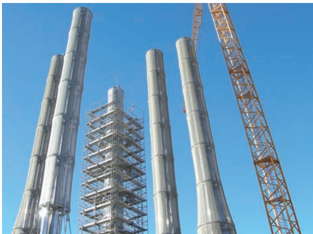
Chimeneas correspondientes a la Central de Recogida de Residuos.
