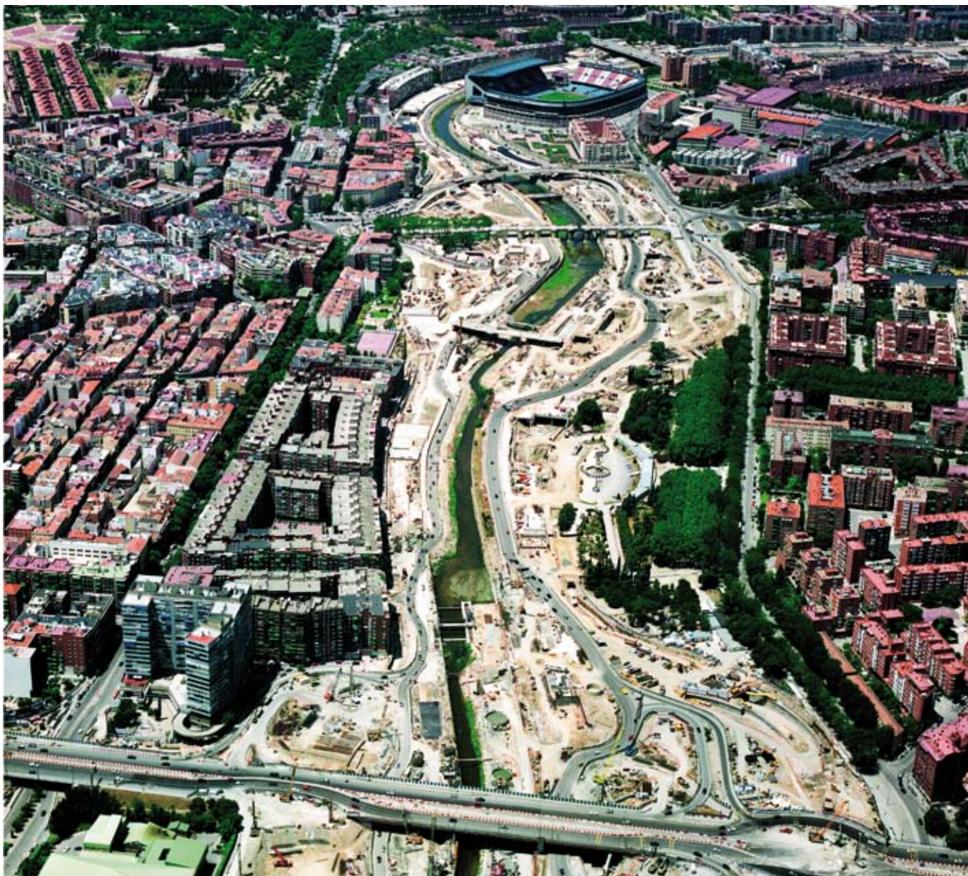
Obras del sector Oeste de Calle 30 en junio 2006
