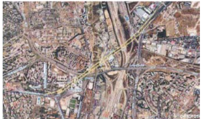
Conexión Bypass Norte con la A-1 (avenida de Burgos)
