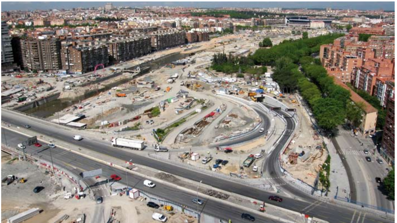
1 y 2 Soterramiento Calle 30 en los tramos entre los puentes de San Isidro y el puente de Praga 3 Estado de las obras en superficie de ese mismo ámbito
