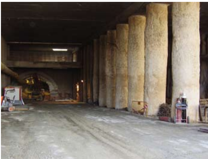
Imágenes correspondientes a la construcción del túnel. 2006
