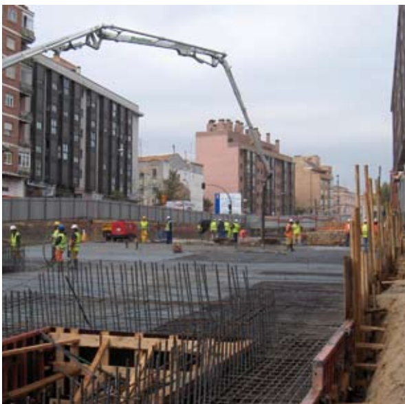
Imagen durante la ejecución de las obras. Diciembre 2006
