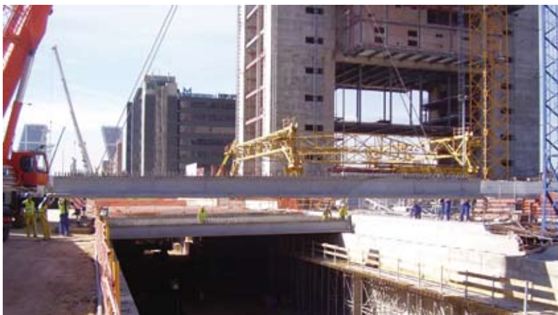
Imágenes tomadas durante la ejecución de las obras. 2006
