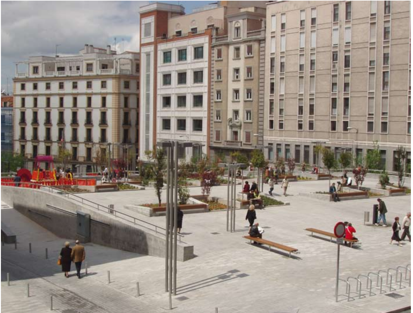
Imágenes correspondientes a la plaza una vez finalizadas las obras. 2007
