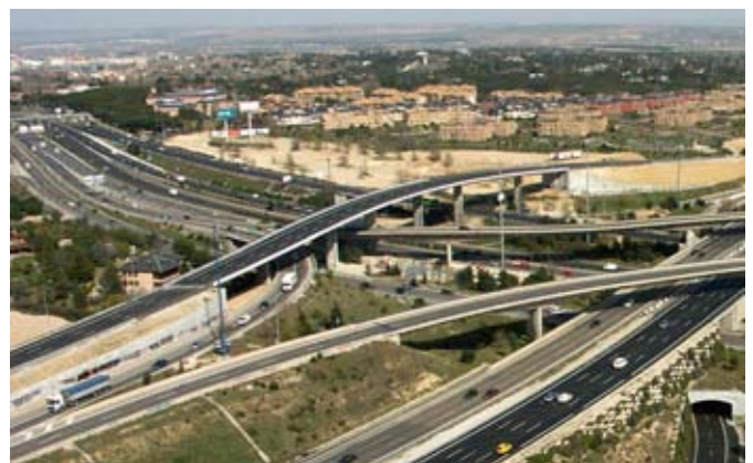
La nueva estructura que cruza sobre la A-1 y el resto de vías de servicio. 2007
