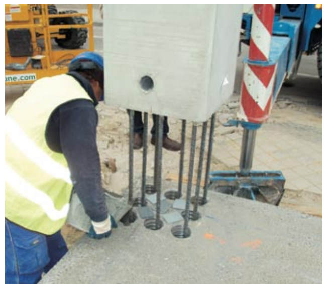
Manubuild. Montaje de pilar prefabricado
