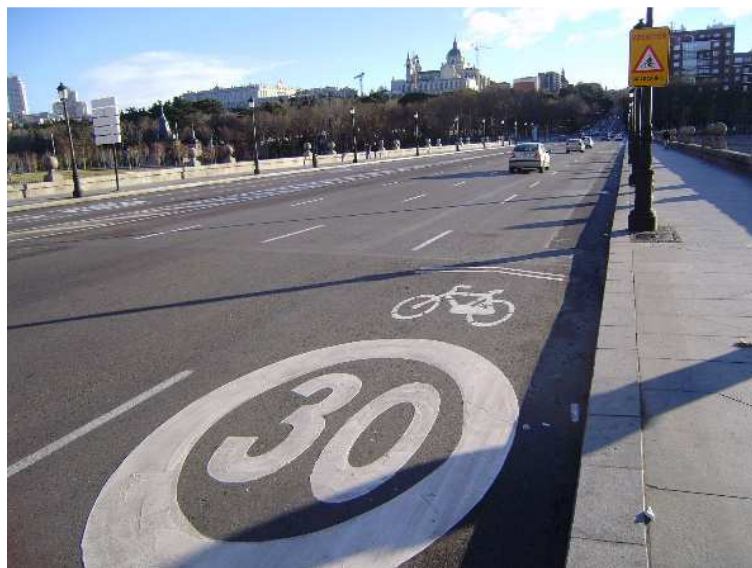
Ciclo carril en calle con varios carriles (Puente Segovia. Madrid)
