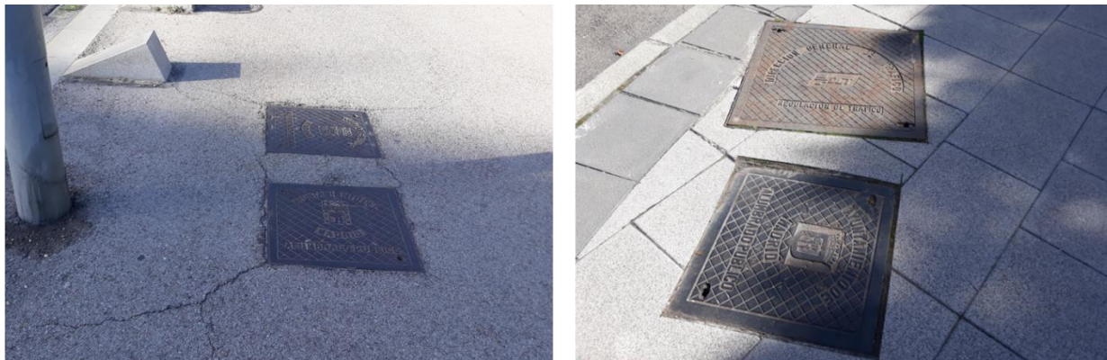
Registros canalizaciones alumbrado en ámbito de proyecto
