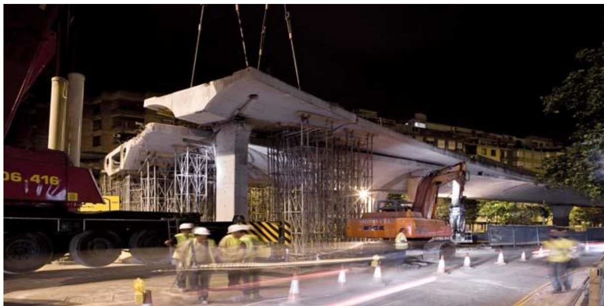
Ejemplo de deconstrucción de los viaductos de la boca sur de túnel de la Rovira. Proyecto y Dirección de Obra ESTEYCO
