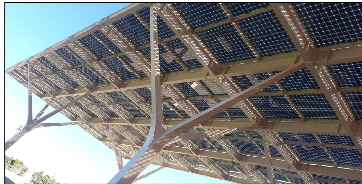
Ejemplo ilustrativo de pérgola fotovoltaica instalada con panel de vidrio fotovoltaico.
