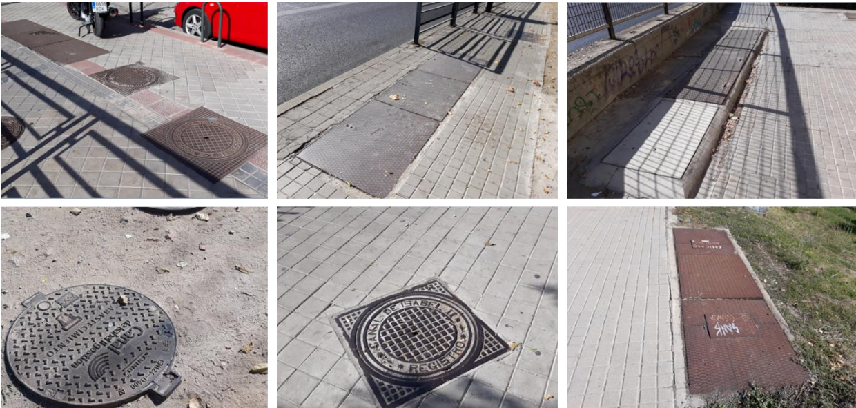
Algunas fotografías de registros existentes de la red de abastecimiento en la zona de proyecto
