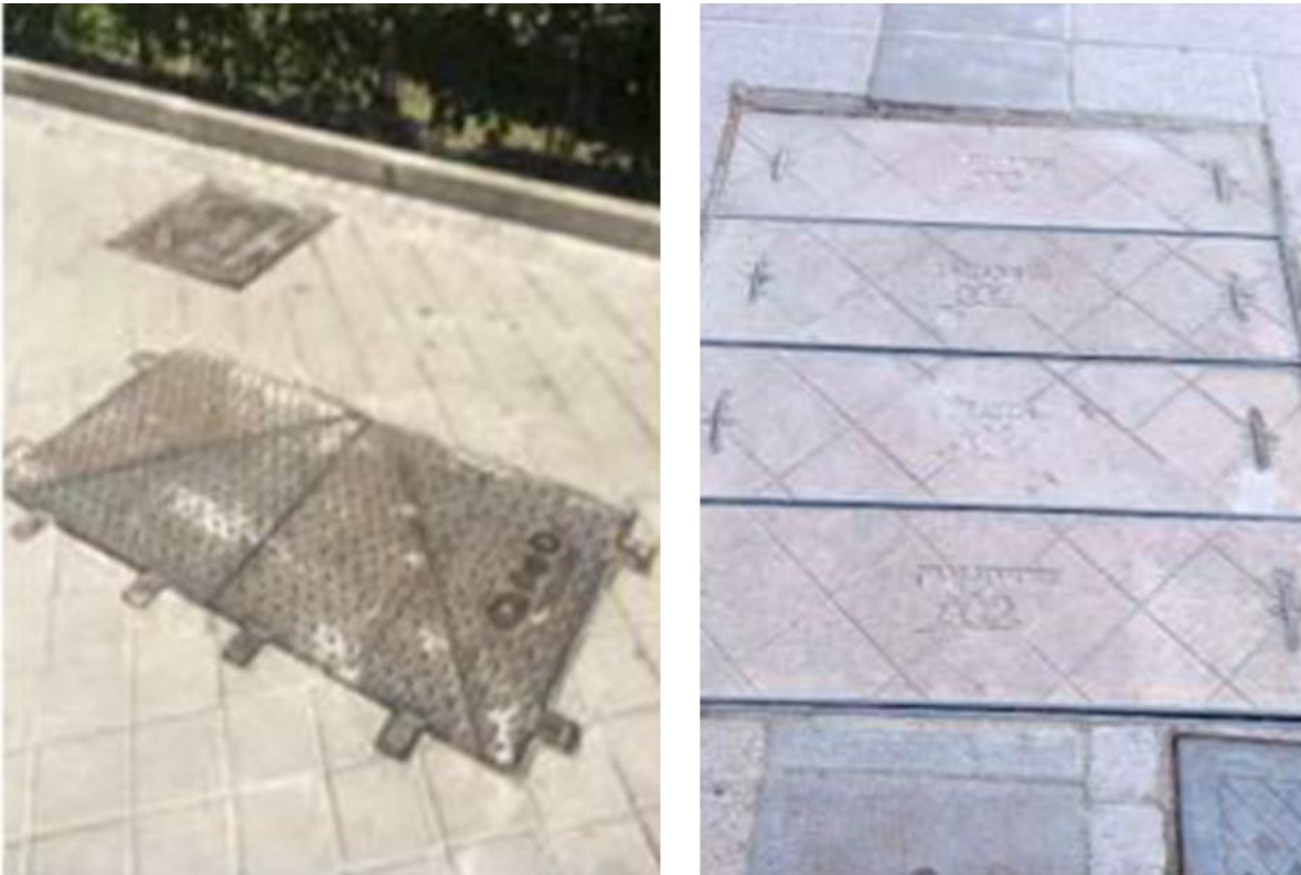
Registros de cámara de acceso a cámaras y arquetas
