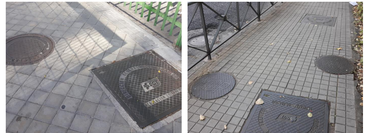
Registros canalizaciones DGT en ambos márgenes en el ámbito de proyecto
