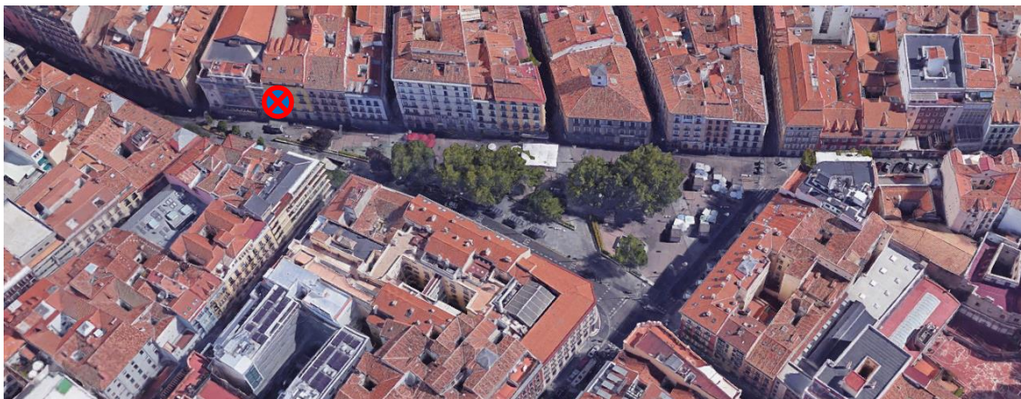
Imagen 76. Situación del Terminal de Monitorizado de Ruido en la Plaza Tirso de Molina 2
