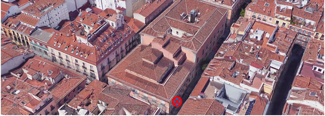
Imagen 53. Situación del Terminal de Monitorizado de Ruido en la calle León 21
