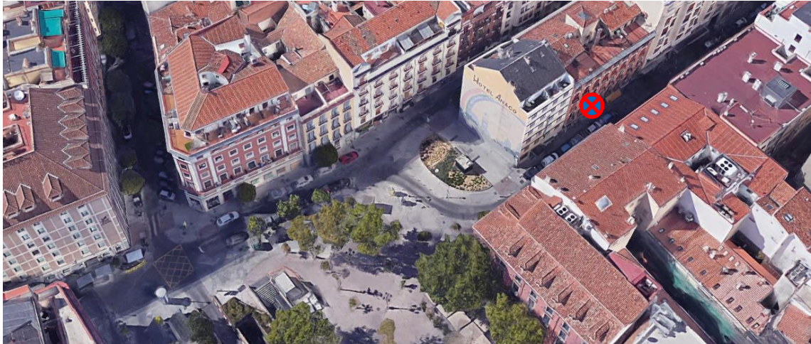
Imagen 89. Situación del Terminal de Monitorizado de Ruido en la Calle Salud 8 (II)
