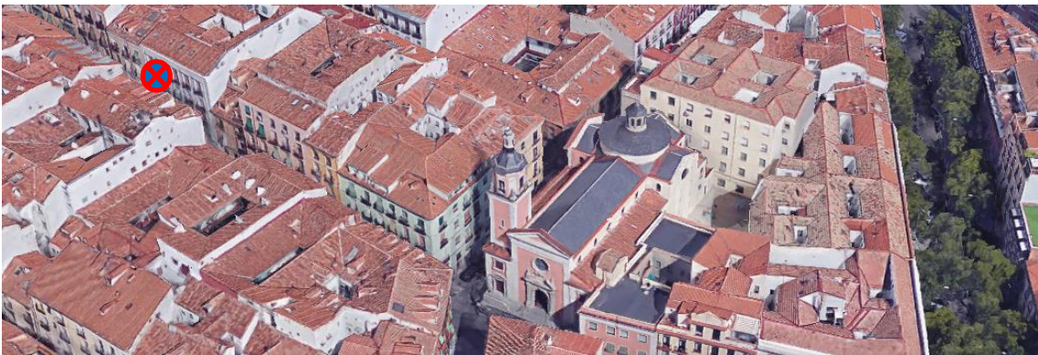
Imagen 36. Situación del Terminal de Monitorizado de Ruido en la Calle Salitre 21
