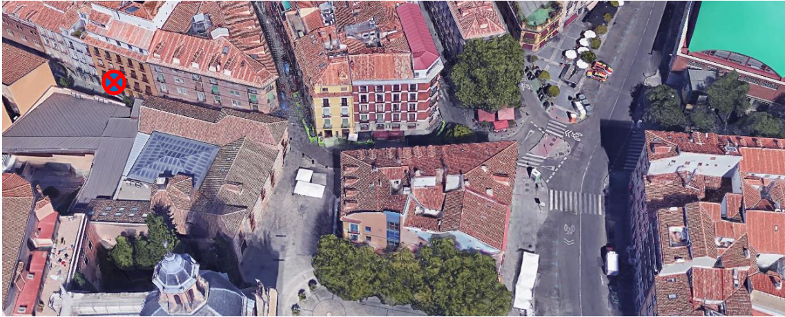
Imagen 49. Situación del Terminal de Monitorizado de Ruido en Costanilla de San Pedro 9
