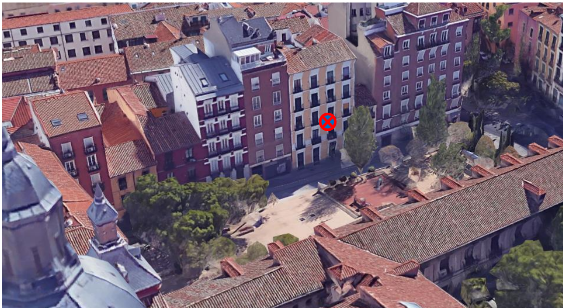
Imagen 64. Situación del Terminal de Monitorizado de Ruido en la Calle La Palma 76
