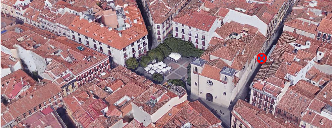
Imagen 35. Situación del Terminal de Monitorizado de Ruido en la Calle Colón 16
