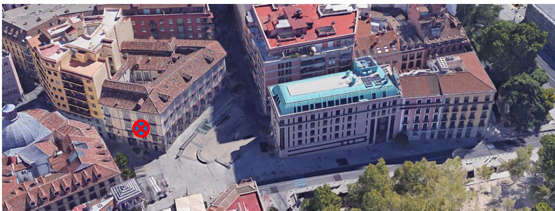
Imagen 74. Situación del Terminal de Monitorizado de Ruido en la Calle Cruzada 4
