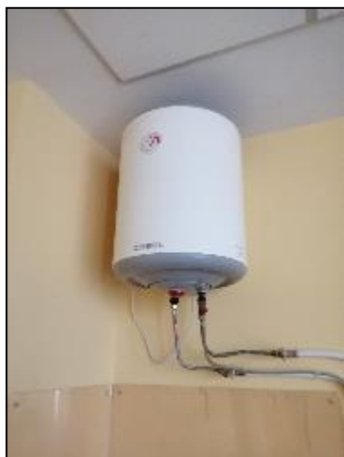
Ilustración 8. Termo eléctrico
