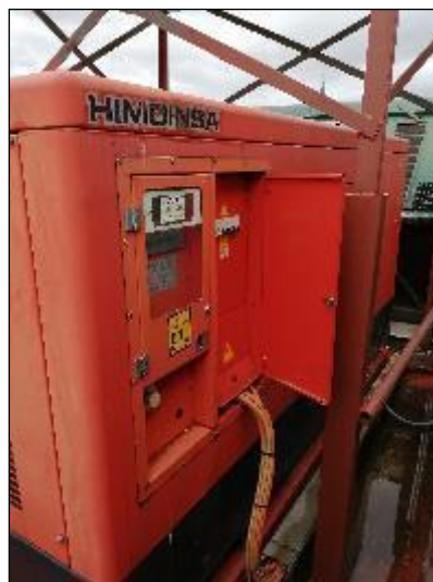
Ilustración 3. Grupo electrógeno
