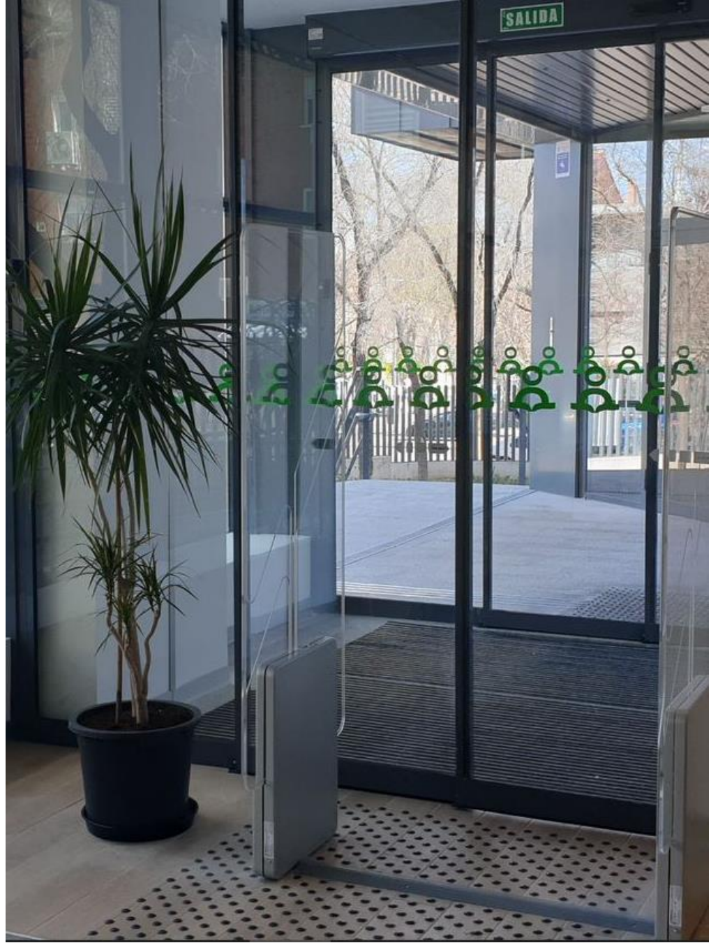
Señalización podotáctil en la Biblioteca de San Fermín
