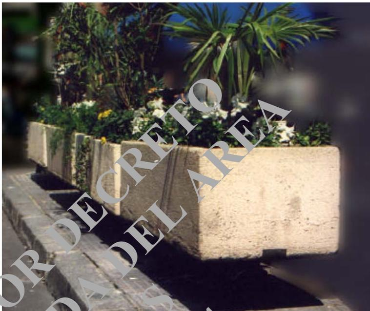
con gravilla vista con un espesor medio en su base de 8 cm. y 5,5 cm en sus caras, con tres agujeros de  $\varnothing$  0,4 cm para facilitar el desagüe
