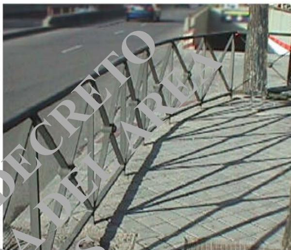
media caña de 60x25x1,5 mm y la parte inferior soldada a la pletina realizada en tubo de 20x20x1,5 mm.
