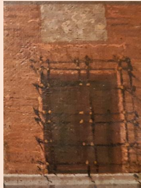
Figura 34. Muros de ladrillo
