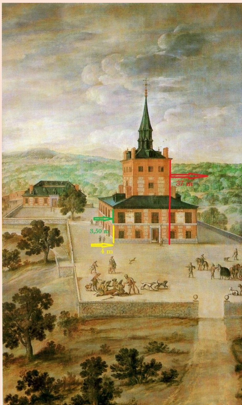
Figura 56. Altura estimada de la Torre.
