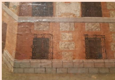
Figura 36. Hiladas de sillares
