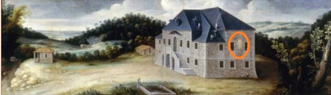
Figura 66. Reloj de sol de la Casa de la Nieve
