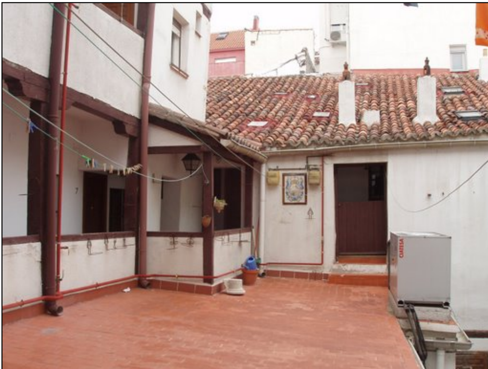
Aspecto de Corrala de vecinos del barrio de Universidad, septiembre de 2007
