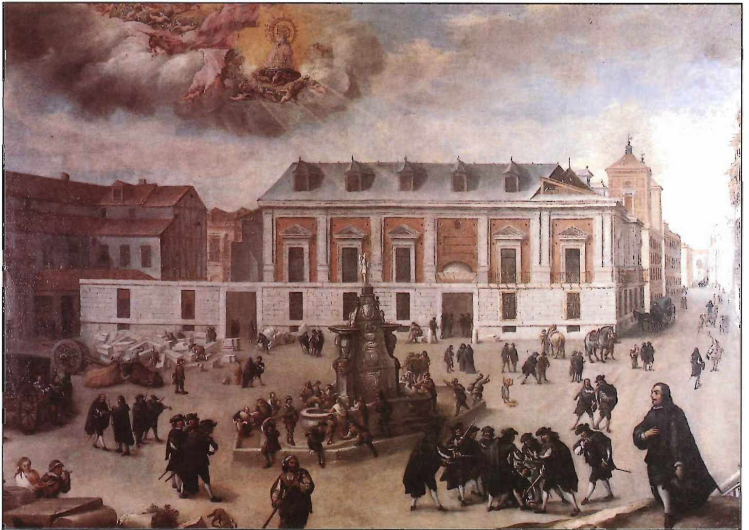
Personajes, costumbres, devociones y lugares madrileños del siglo XVII. (El Milagro de la Virgen de Atocha en las obras de construcción de la Casa de La Villa. Óleo anónimo. Museo Municipal).
