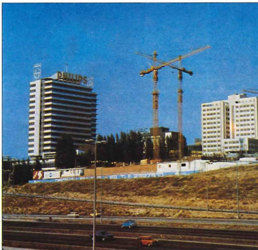
Ilustración 5. Sobre el arroyo Alto Abroñigal se trazó el tercer cinturón de ronda, la M-30.
