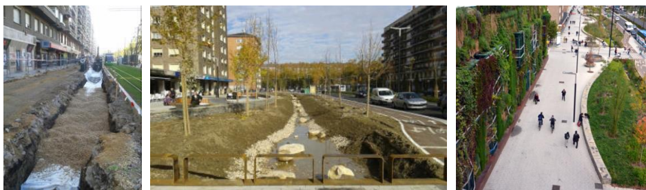
Figura 17. SUDS en Vitoria-Gasteiz. Fuente: Ayto. de Vitoria-Gasteiz (2017).
