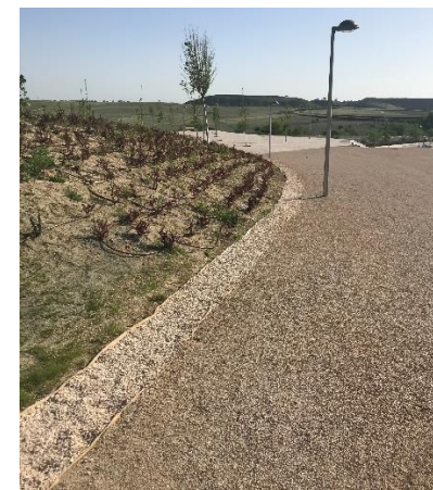
Zanja de infiltración en La Atalayuela, en Madrid. Fuente: Ayto. de Madrid.
