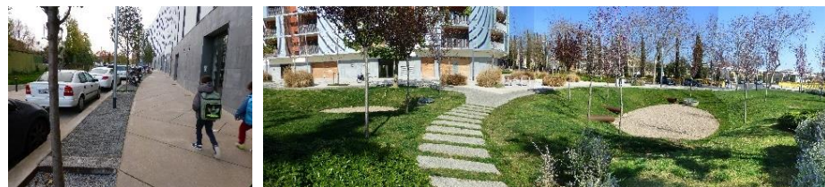
Figura 15. SUDS en Can Cortada (Barcelona). Fuente: Instituto Municipal de Urbanismo, Ayto. de Barcelona.
