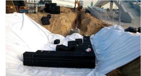
Construcción de un depósito de infiltración con cajas reticulares en la Nueva Sede BBVA en Madrid.
