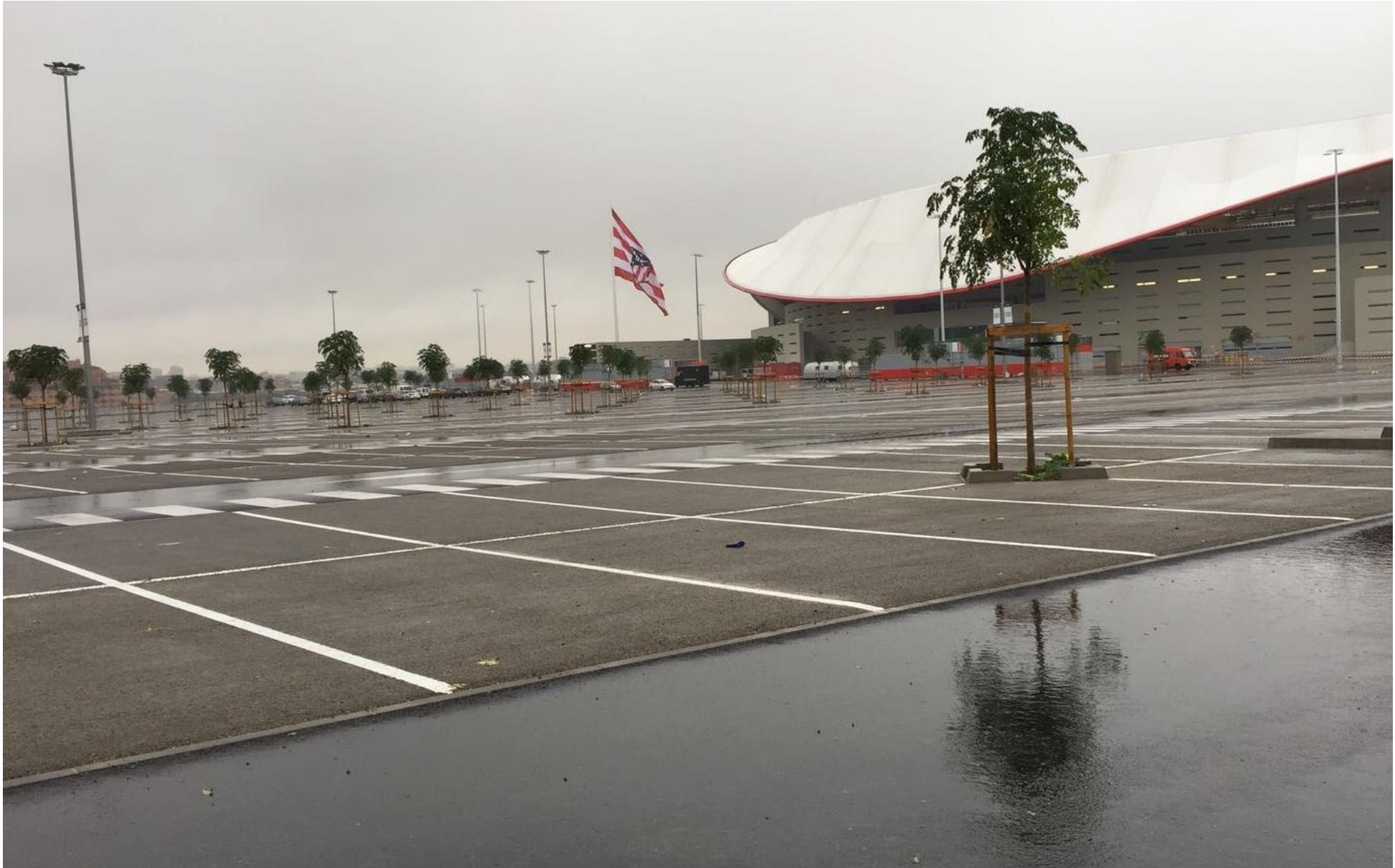
Aparcamiento de hormigón poroso en el Estadio del Atlético de Madrid. Fuente: Ayto. de Madrid.
