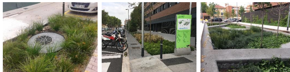
Figura 14. SUDS en el barrio de Bon Pastor (Barcelona). Fuente: Instituto Municipal de Urbanismo, Ayto. de Barcelona.
