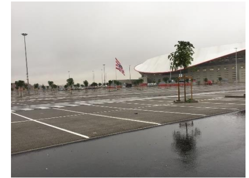
Aparcamiento de hormigón permeable en el Estadio del Atlético de Madrid. Fuente: Ayto. de Madrid.
