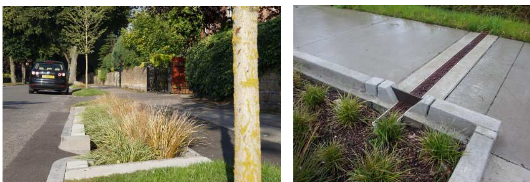
Fig.3. Sistemas de drenaje sostenible.
