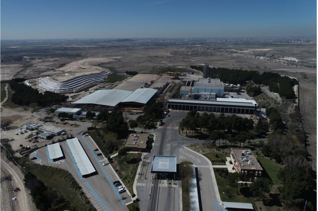
Vista aérea de la planta
