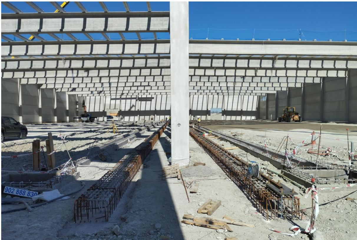
Montaje de la cubierta de tratamiento biológico
