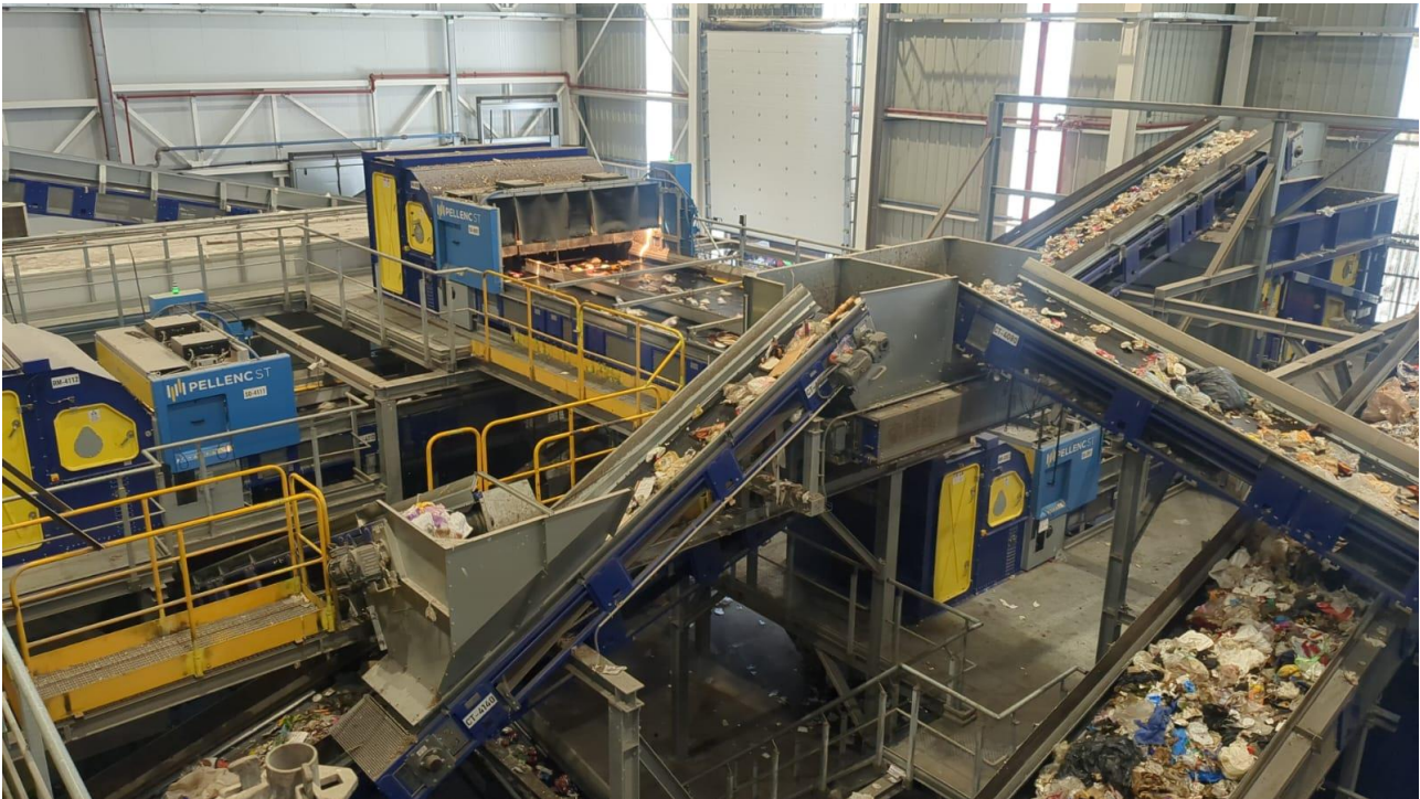
Cintas transportadoras de la nueva planta de separación y clasificación
