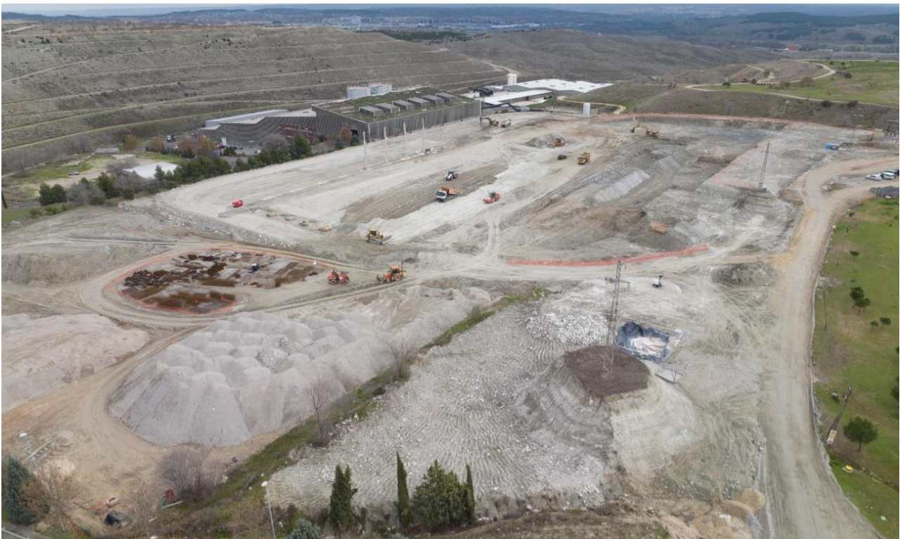
Situación de la obra a comienzos de 2023.
