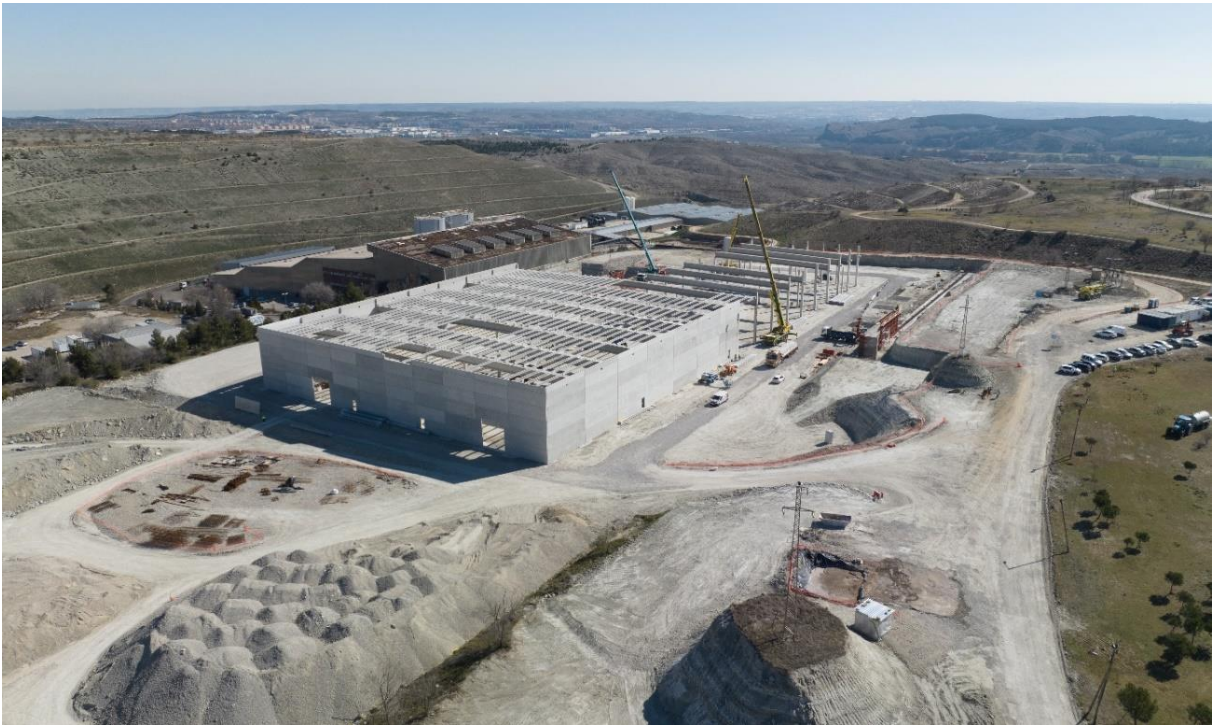
Montaje de la estructura prefabricada
