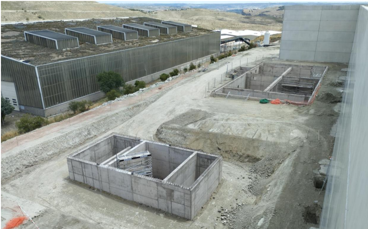
Ejecución de depósitos enterrados.
