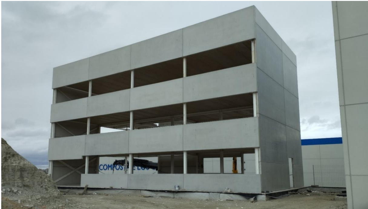
Edificio de oficinas
