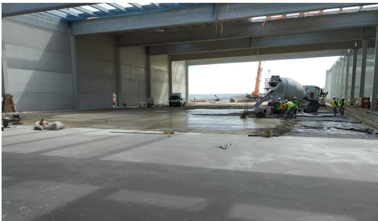
Ejecución de soleras.
