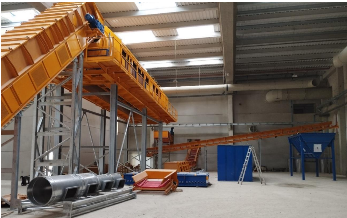
Instalación de trómel
