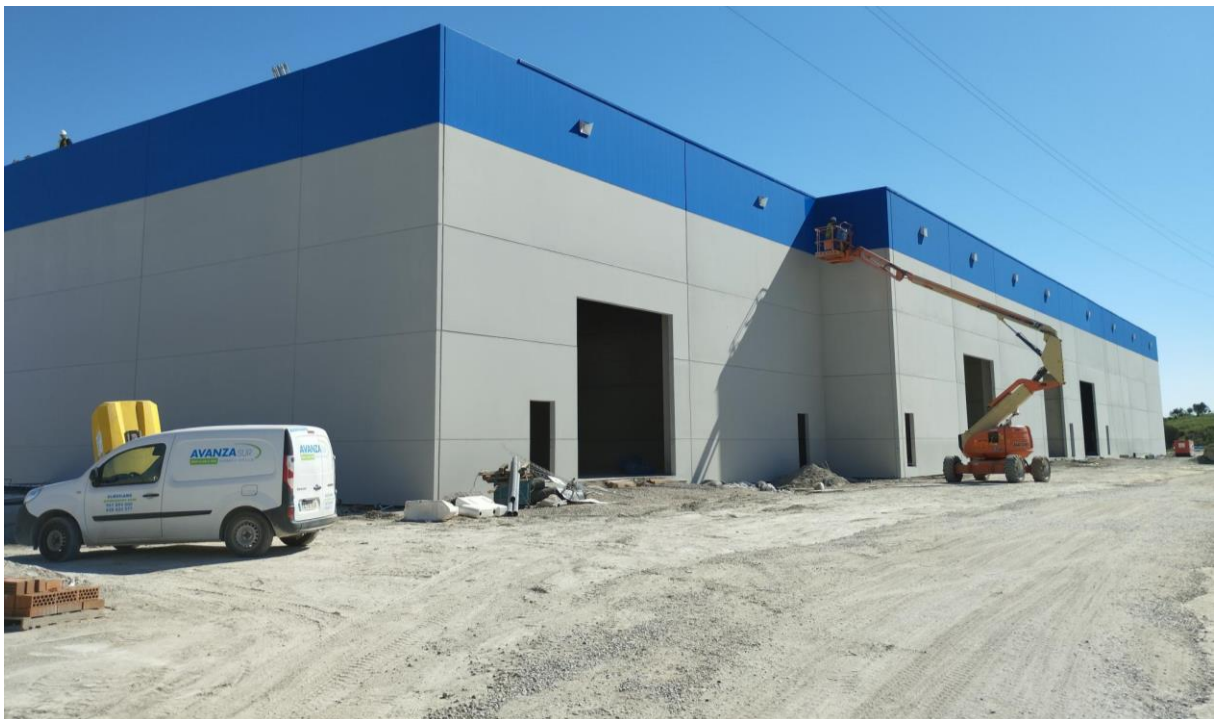
Cerramiento de naves de recepción.
