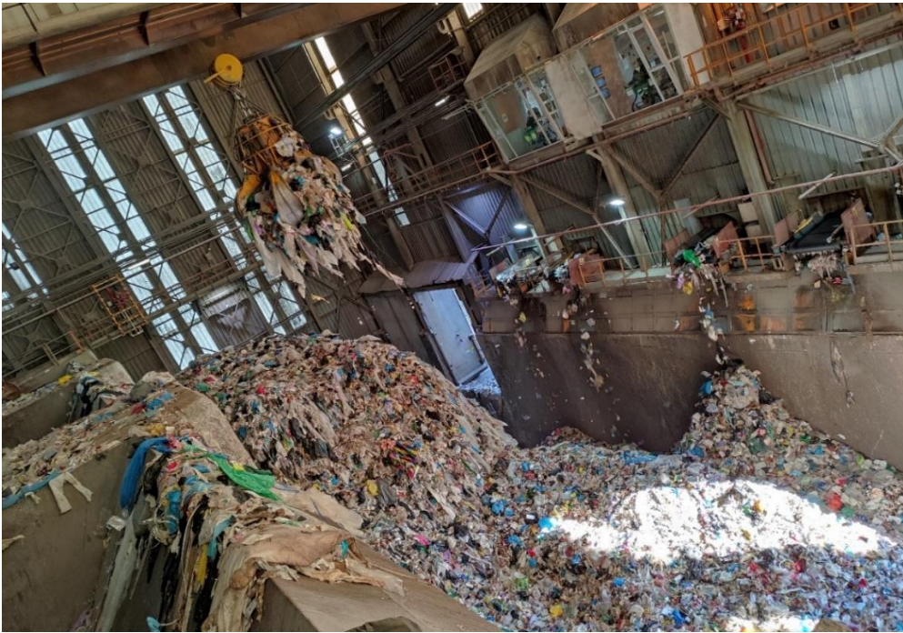
Foso de RDF donde se almacenan los rechazos que se someten a valorización energética en Las Lomas
