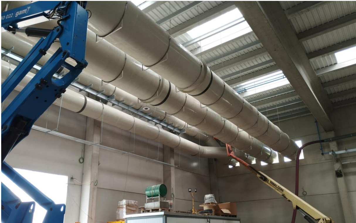
Montaje del sistema de desodorización.
