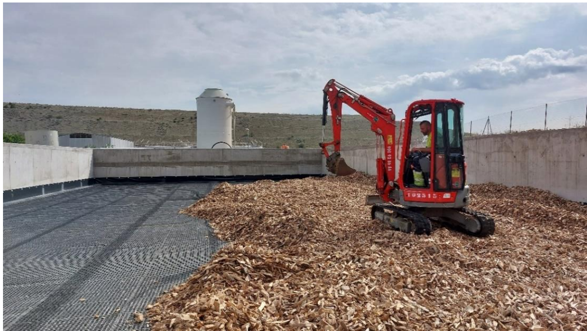
Colocación del biomedio orgánico en el biofiltro de nueva construcción en la Paloma
