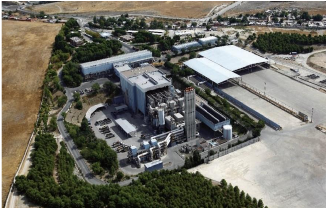
Figura 1. Planta de tratamiento de residuos municipales de LAS LOMAS en Valdemingómez
