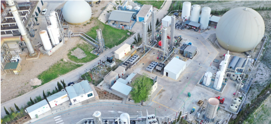
Figura 21: Planta de Tratamiento de Biogás (PTB) de Valdemingómez
