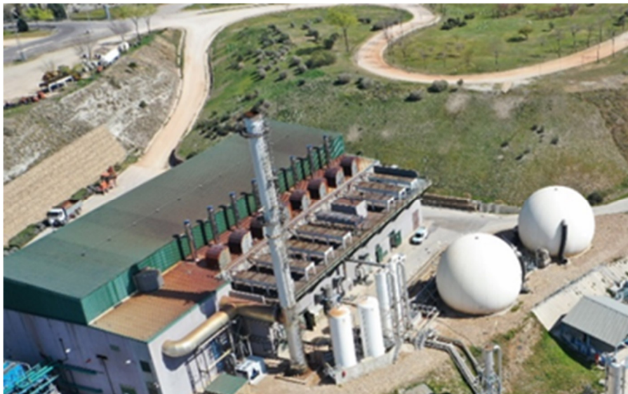
Figura 22: Instalaciones de La Galiana. Fuente: Dirección General del PTV.
