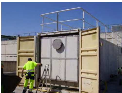
Túnel Piloto en la planta de tratamiento de R.S.U. Las Dehesas, del Parque Tecnológico de Valdemingómez.
