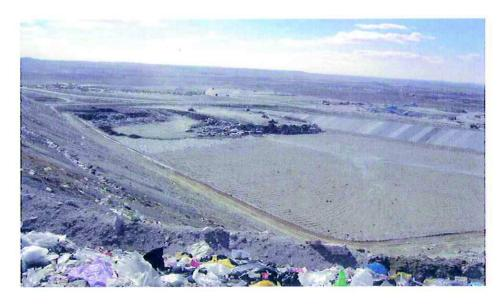
10.- Desgasificación del vertedero controlado de cola. La extracción del biogás del vertedero se lleva a cabo mediante pozos de captación de biogás, estaciones de regulación y medida (ERM) y una central de extracción secundaria para el envío del biogás a la central de valorización energética. La instalación de los pozos y la red de conducción de biogás se completa a medida que se colmatan las celdas del vertedero en explotación.
