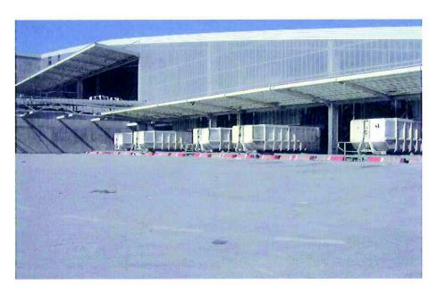
**8.- Planta de tratamiento de lixiviados.** Su capacidad de tratamiento actual es de 50 m³ diarios, ampliable hasta 200 m³/día en función de las necesidades (número de celdas del vertedero). El tratamiento se realiza mediante un proceso de ósmosis inversa en tres etapas.
