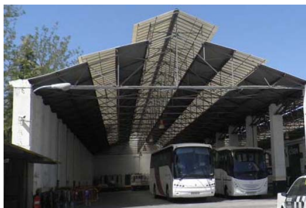
Nave de almacenamiento de señalización portátil
