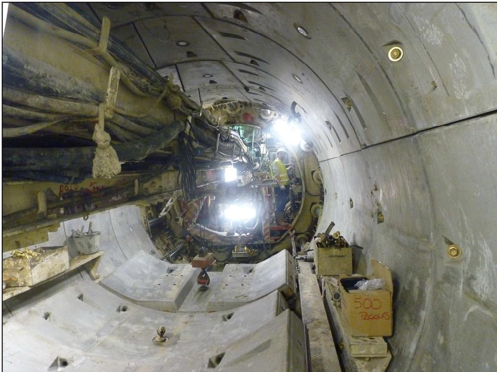
Vista frente de la tuneladora (cinta de extracción de escombros y erector de dovelas)
