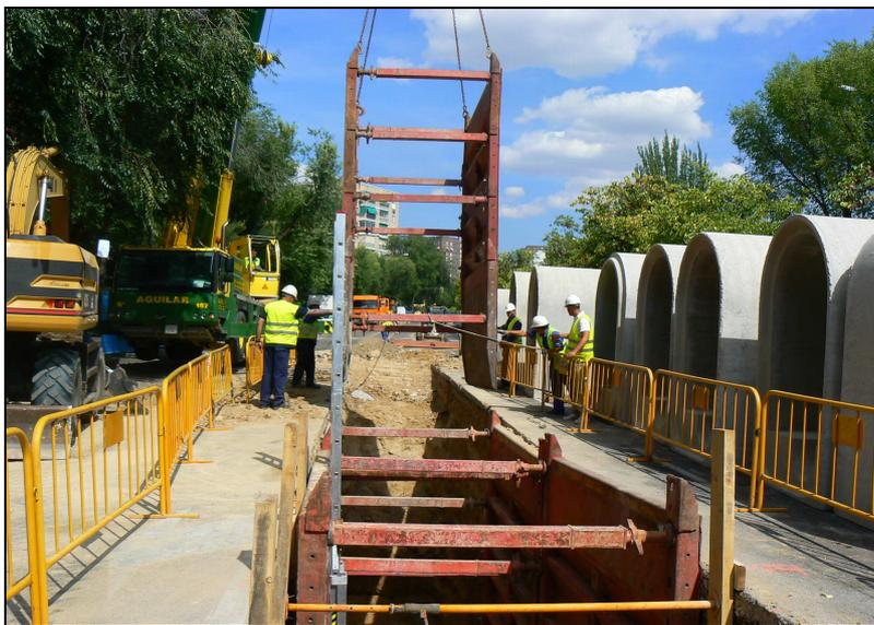
Entibación zanja para colocación de prefabricad
