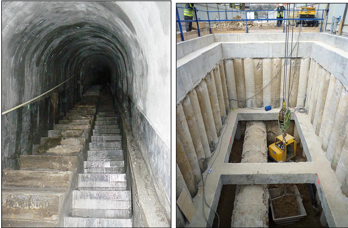
Tramo de galería inclinada con 40% de pendiente Ejecución Arqueta de conexión colector existe
