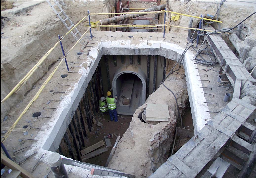
Ejecución de Arqueta conexión colector existente
