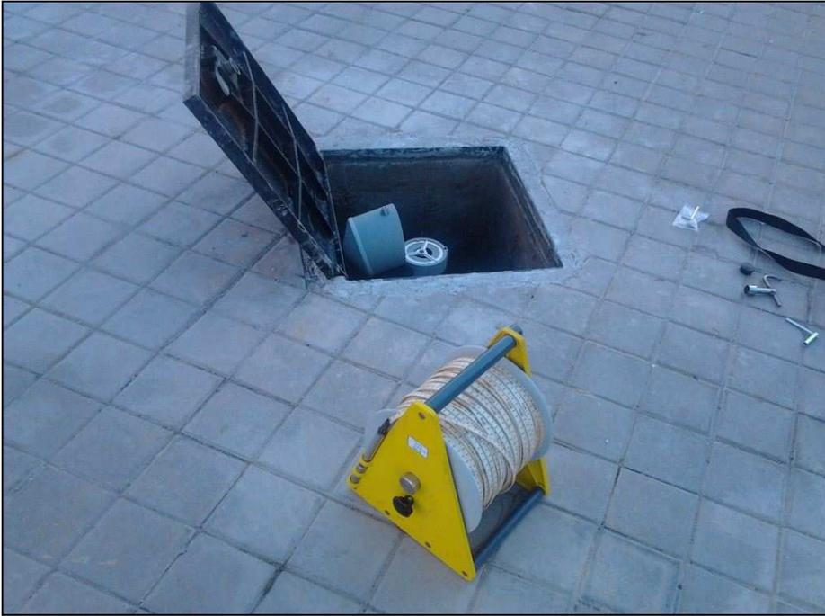
Instalación de medidores automáticos de nivel freático
