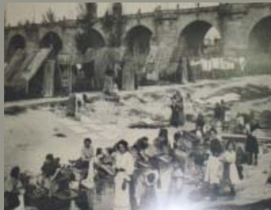
Fotografía de 1906 en las inmediaciones del Puente de Toledo, en la que se observa el reacondicionamiento del cauce del río similar al localizado en el Puente de San Isidro.
