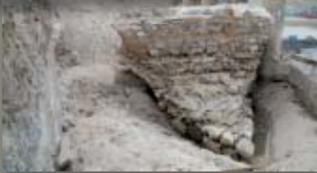
Embocadura, pila y arcos de La Puente Segoviana hallados aguas arriba del Puente de Segovia. Han sido desmontados para su puesta en valor.
