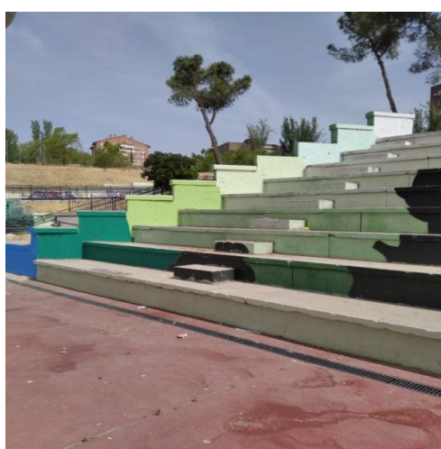
Colaboración en el acondicionamiento de la Instalación Deportiva Básica El Hoyo
