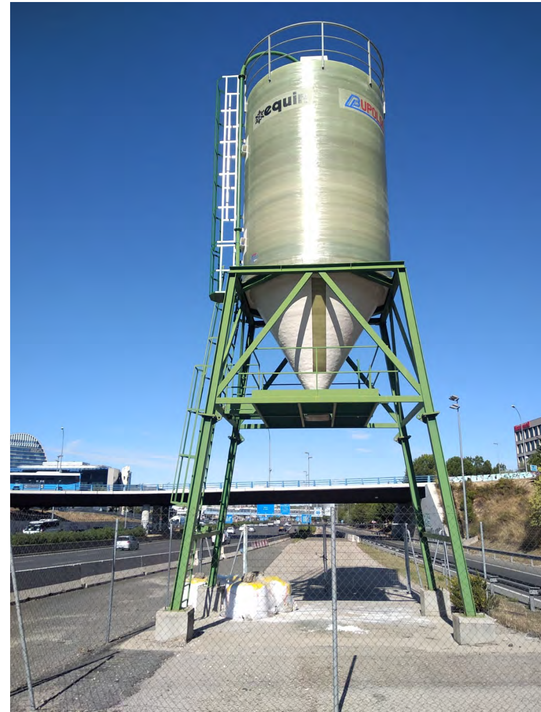
Fot. 2 fotografía de silo de sal de 60 tm en A-1
