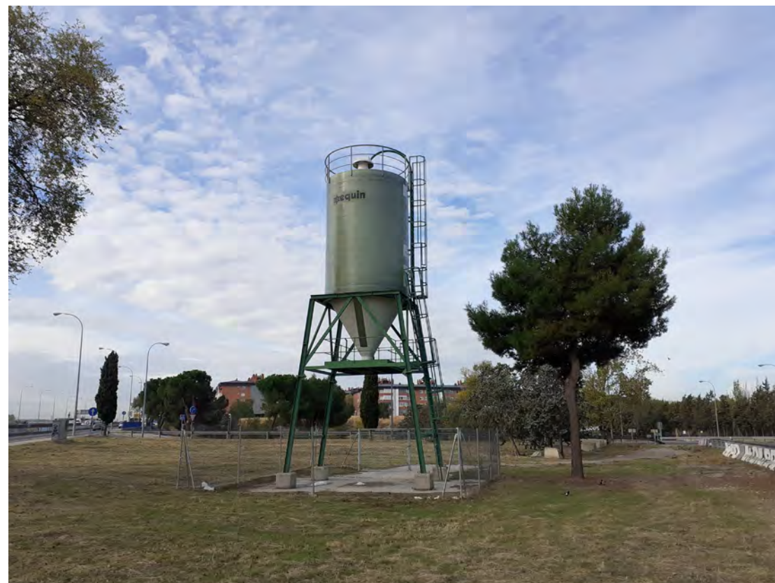
Fot. 4 fotografía de silo de sal de 60 tm en A-5
