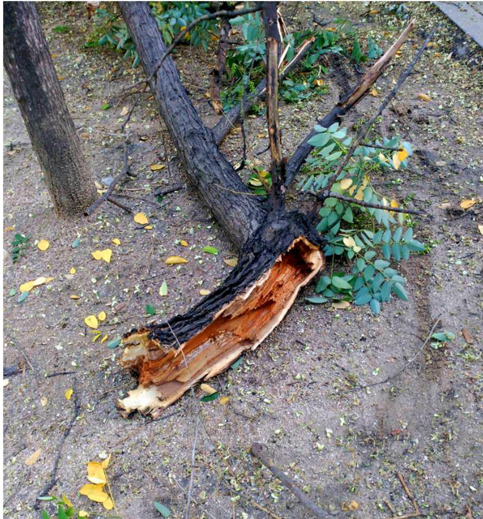
Plan de regeneración del arbolado del Paseo de la Castellana. Defectos en los árboles
